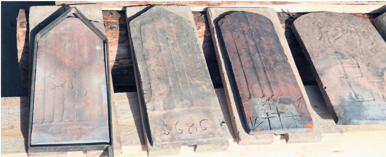
Formenvielfalt bei den Biberschwanzziegeln (alle von Buchberger Dächern). Einige – sogenannte «Fiirabiziegel» – erhielten besondere Markierungen. Beim zweiten von links erstaut das hohe Alter (1686), beim dritten sind drei Golgatha-Kreuze eingeritzt. Über dem ersten liegt eine bei der Herstellung verwendete Form. Bild: vf
