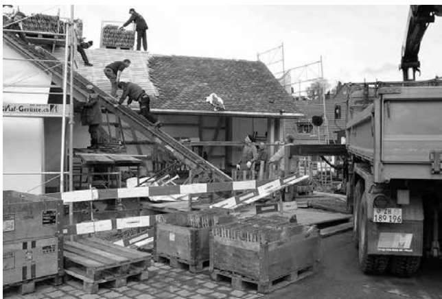
Dach decken im April 2010
