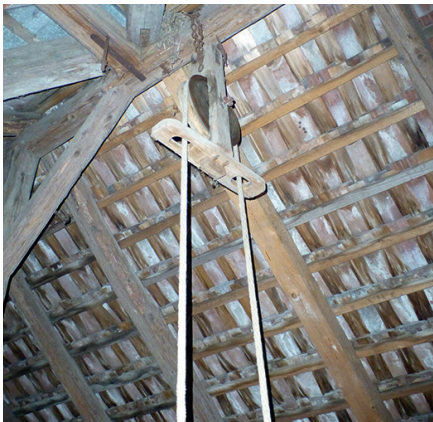
Brügiöse mit Rolle im First einer Scheune in Buchberg; Bild im April 2017
