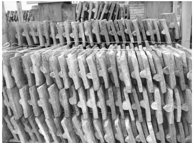
Palette mit zum Decken vorbereiteten ur-alten Biberschwanzziegeln
