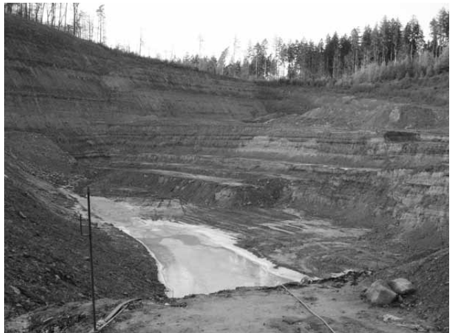
Lehmgrube der Zürcher Ziegeleien ZZ WANCOR, Rafz mit den 35 Meter hohen Wänden mit idealem Lehm für die Herstellung von Backsteinen
