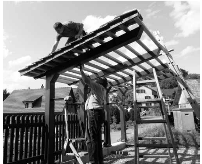
Otto Haller und Hanspeter Fehr decken das zukünftige Holzlager einfach mit alten Biberschwanzziegeln und Holzschindeln. Hans Nössing hat die robusten Stützen angefertigt.
