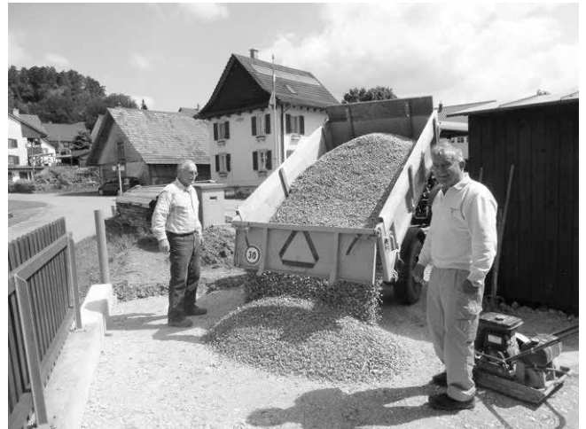
Sepp Schneider & Robert Kern beim Kiesablad für den Holzschpfboden
